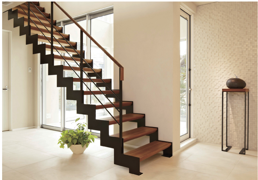
施工例 黒のイナズマ形のササラに、踏板はウォルナット化粧板貼
